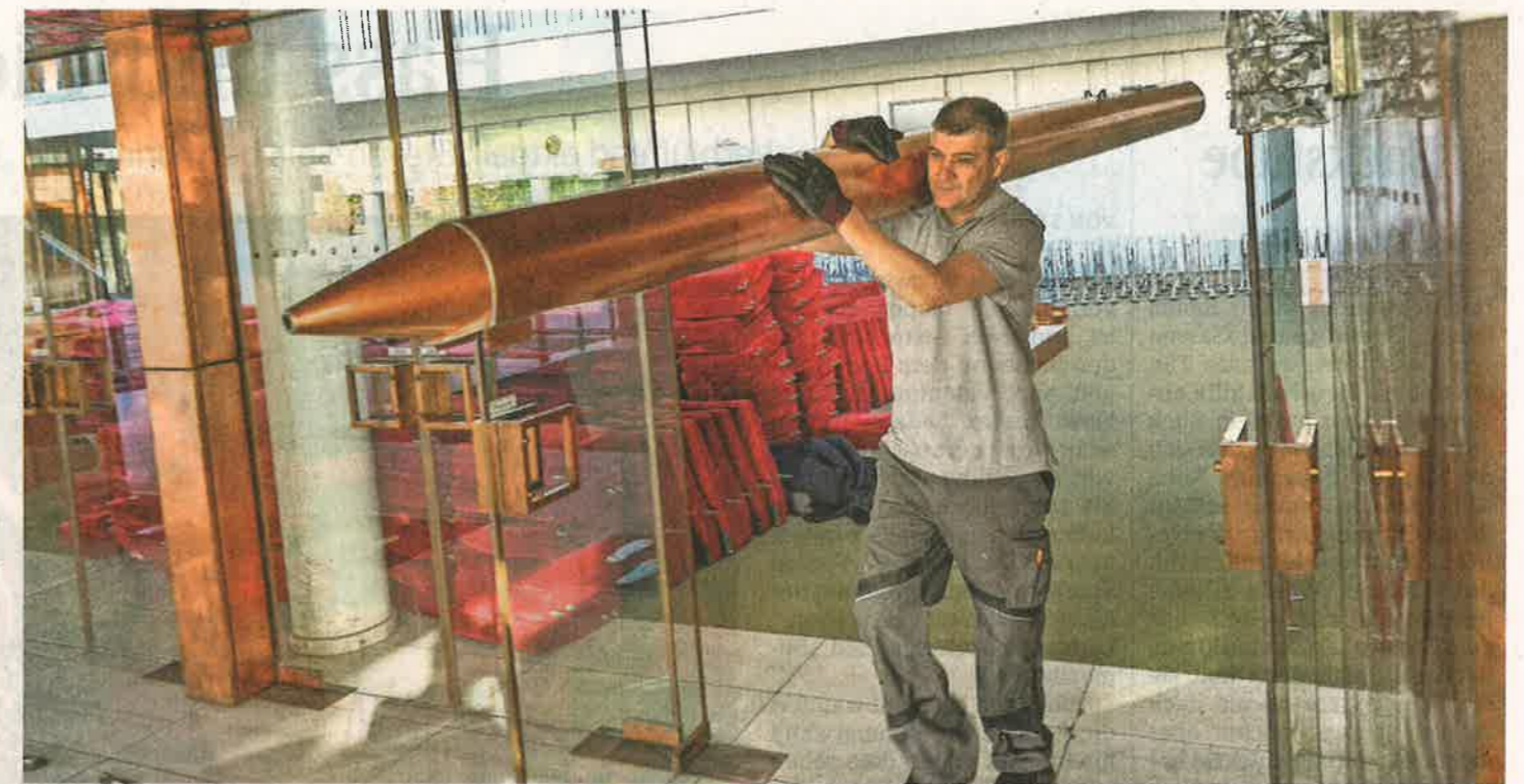
Abbau und Einlagerung der Orgel im Konzertsaal am Kieler Schloss: Alexander Resner von der Hamburger Orgelbaufirma von Beckerath trägt eine mächtige Kupferpfeife des Prinzipal-16-Fuß-Register aus dem Foyer.
