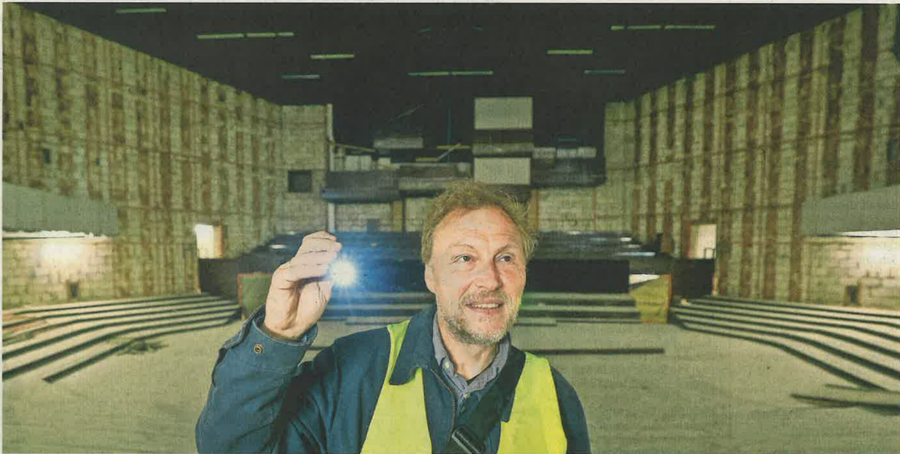
Rohbau-Ambiente: Projektleiter Hendrik Euling-Stahl im entkernten Konzertsaal am Kieler Schloss.
