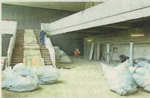
Müllsäcke bestimmen derzeit das Ambiente im Foyer, wo später rechts die Bar eingerichtet wird.
