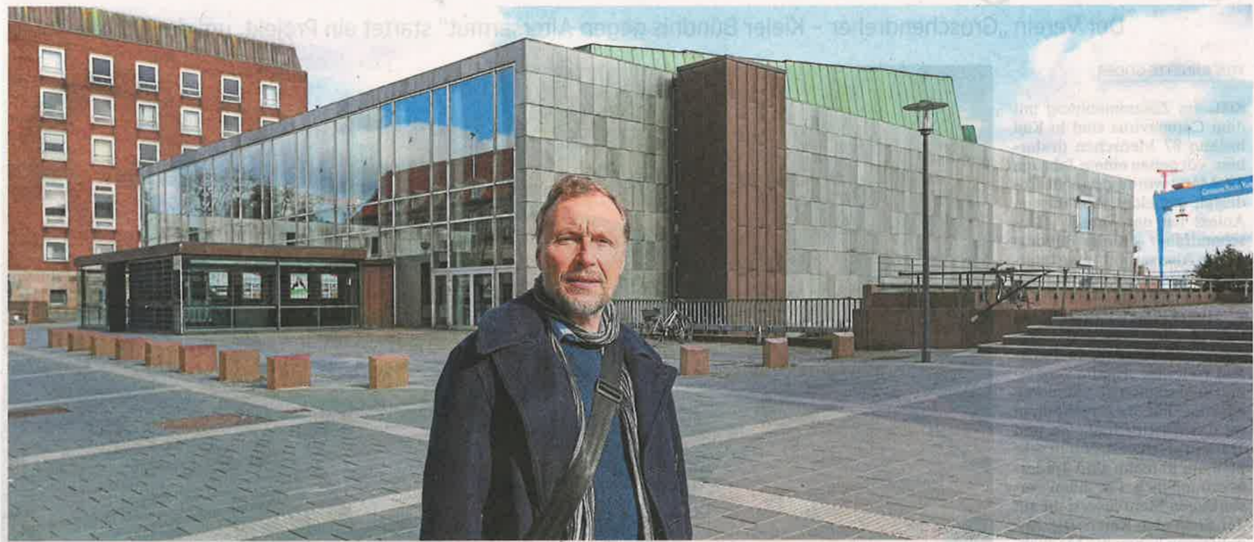
Der Konzertsaal am Kieler Schloss wird ab Ende August zur Baustelle: Hendrik Euling-Stahl ist Projektleiter der bis 2024 angesetzten Sanierung.
